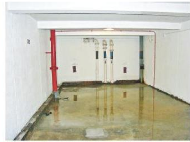
過去每逢大雨，愛民邨地下3個樓層經常會出現滲水，甚至出現圖中大量積水的情況。（房屋署提供）
